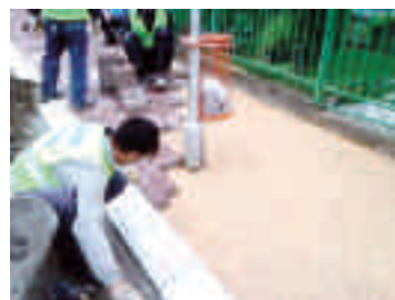
Сл. 7 Раб од бетонски блокови
